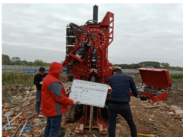
PowerProbe 双套管连续取样
